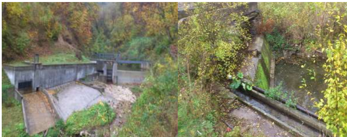
Река Сивяк до с. Потока и р. Козята (граница на парка). Напречно строително съоръжение (бент)
