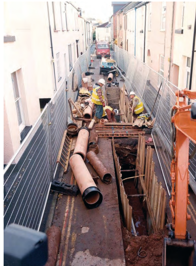
Изграждане на канализационен колектор
