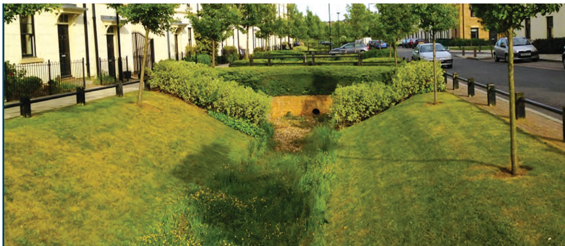
Отводнителен канал като компонент на УОС
