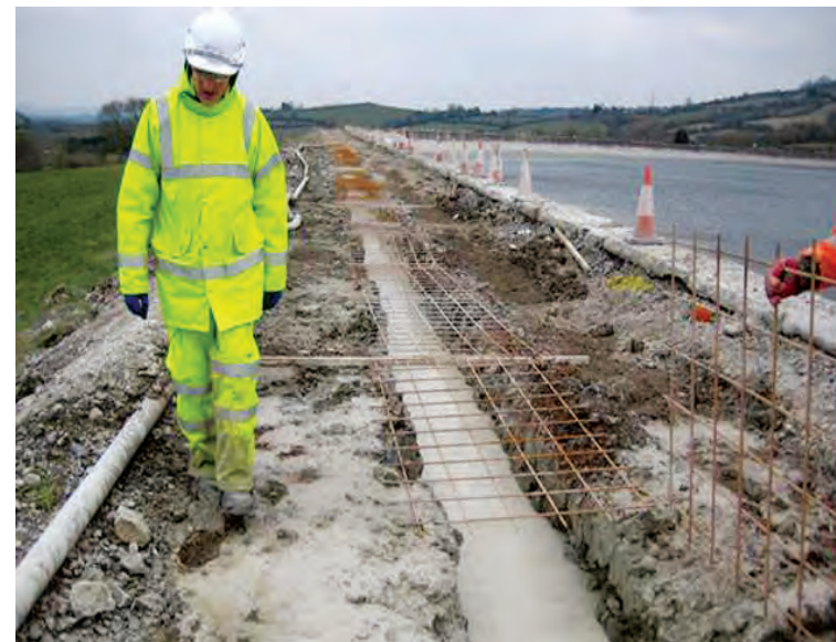
Ремонт на короната на язовирна стена
