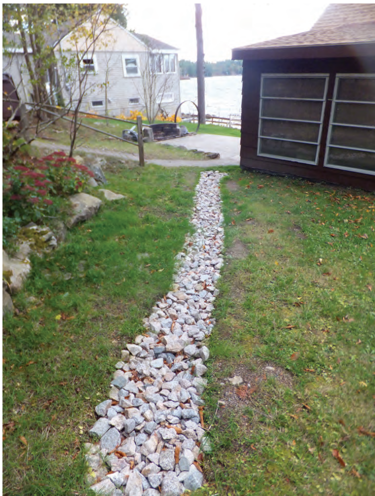
Инфилтрационна поливна траншея като компонент на УОС
