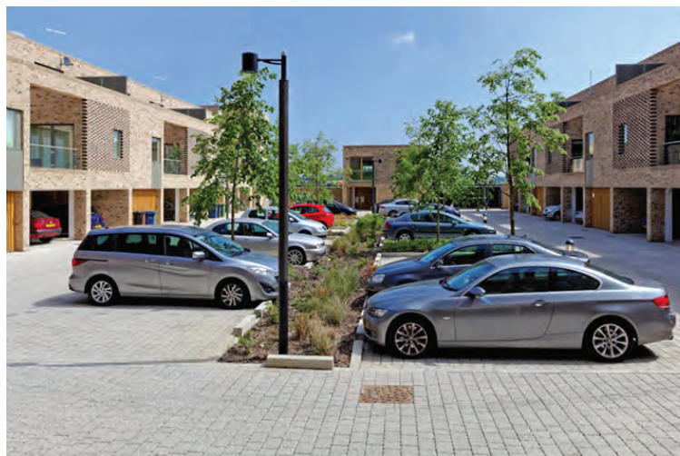
Пропусклива настилка като компонент на УОС
