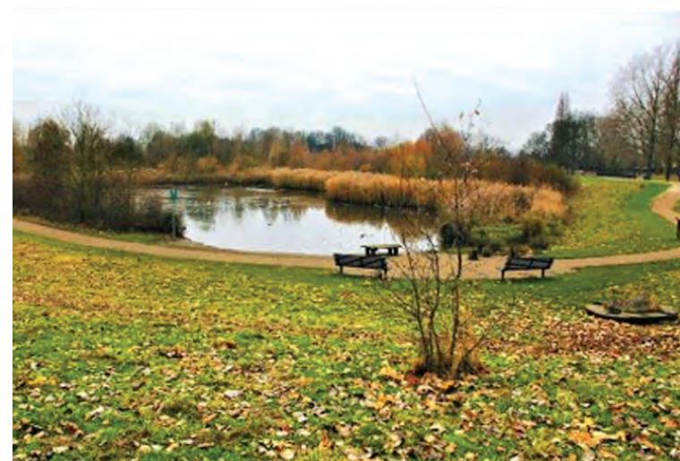
Ретензионно езеро като компонент на УОС
