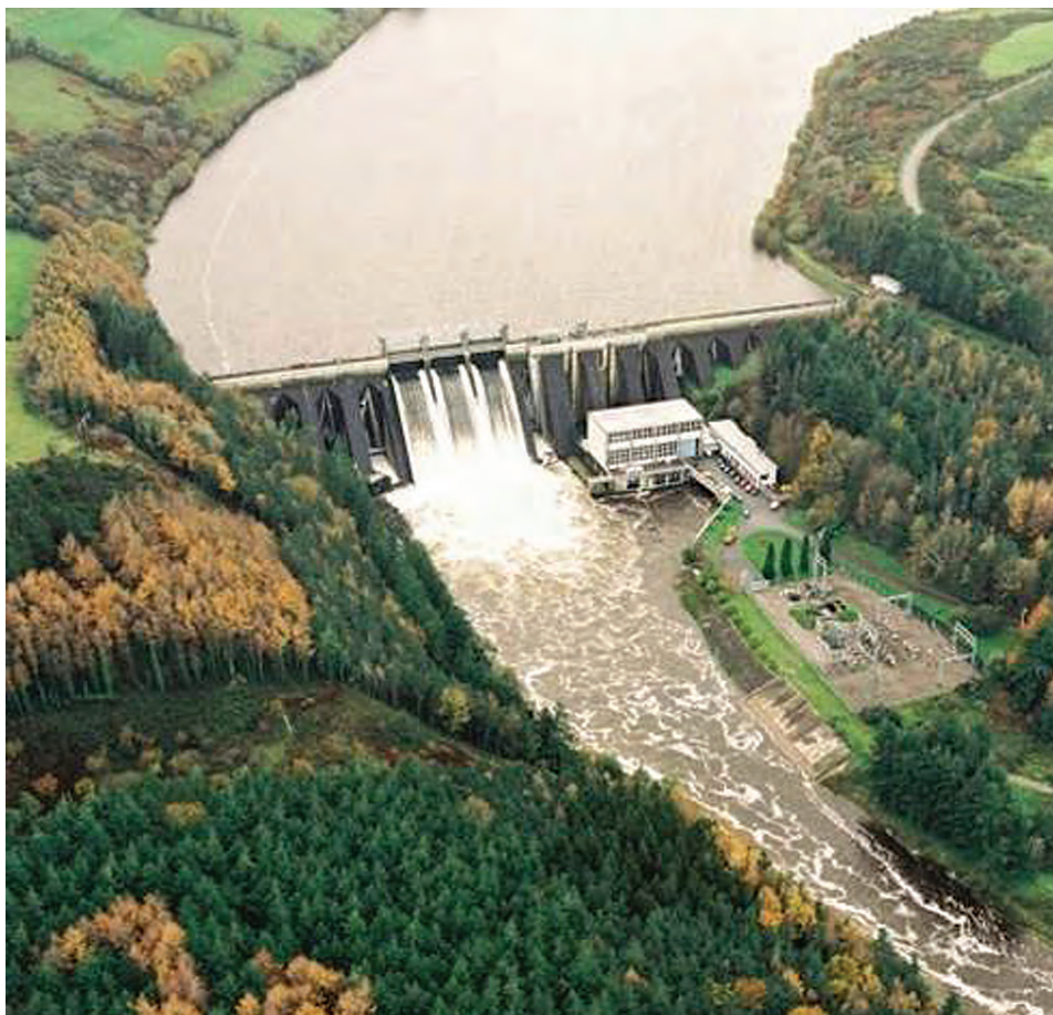
Язовир в Ирландия. Контролирано изпускане води надолу по течение чрез затворни органи, инсталирани на преливника на язовирна стена
