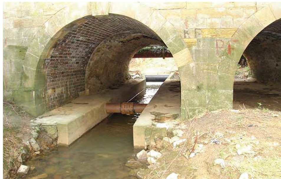
Примери за мостове, които ограничават проводимостта
