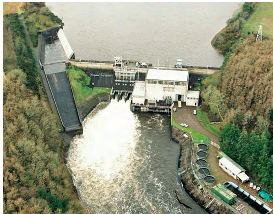
Язовир в Ирландия. Контролирано изпускане води надолу по течение чрез изпускателни съоръжения
