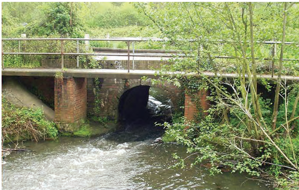
Примери за мостове, които ограничават проводимостта
